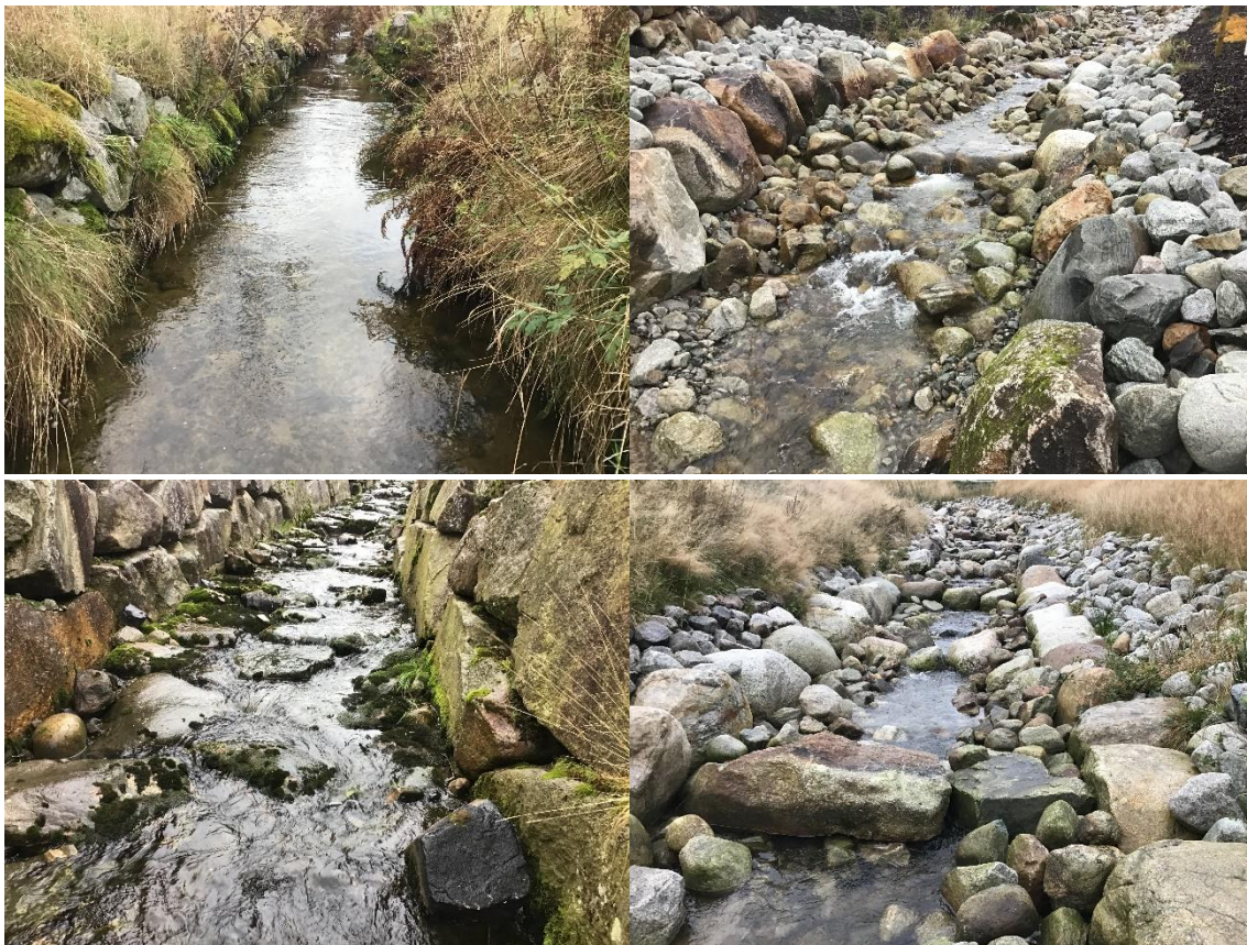
Figur 6.36.4. ØV: Glattstrøm i kanalisert del nederst i elva, nær det viktigste gyteområdet. ØH: Stryk i nedre del av boligområdet, med ny erosjonssikring i form av blokker. Tiltaket er justert ved å fjerne store mengder rullestein og enkelte blokker, for å lette fiskens vandring. NV: Nyere erosjonssikring i stryk øvre halvdel av bekken, sikring av kanter og bunn med blokker. Noen blokker i bunn er fjernet for å lette fiskens vandring. NH: Samme stryksone som bildet over. Blokker er lagt ut og danner terskler. Rundt halvdel av tersklene ble justert ved tiltak i 2021. Ved lav vannføring kan flere av disse utgjøre vandringshinder for større fisk. Ved flom kan også mindre åpninger i tersklene tettes med rullestein, slik at det også blir vandringshinder for mindre fisk.
