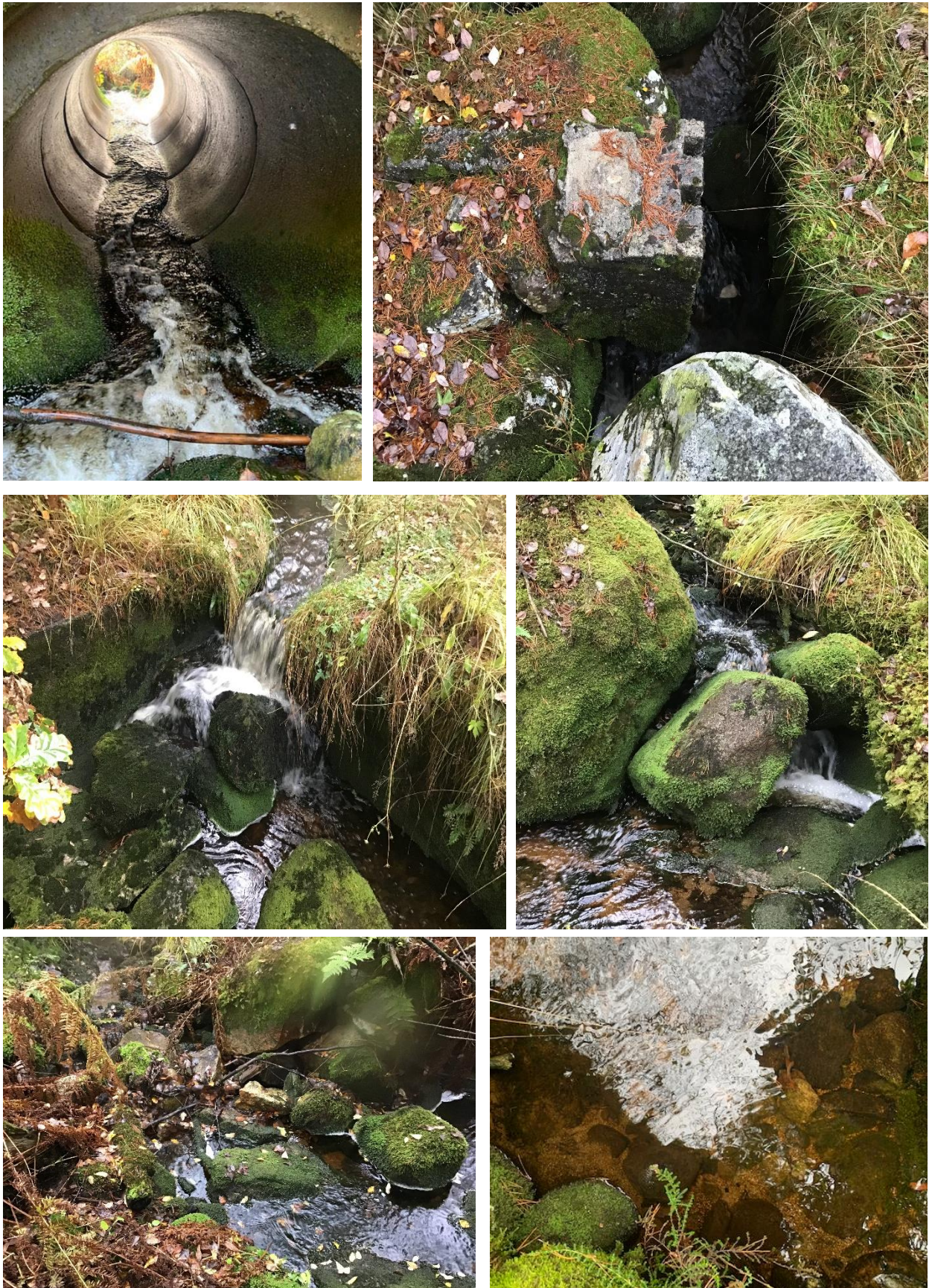
Figur 11.8: ØV: Ett temporært vandringshinder er en rørgjennomføring som tidvis vil ha svært lav vannsøyle. ØH: Betongkloss og blokk danner en trang passasje i bratt del av bekken. Dette er tilnærmet et stengsel for fisken MV: Betongtersel med høyt fall under kombinert med blokker på feil sted danner et stengsel ved de fleste forhold. MH: Det finne flere naturlige, temporære hindre i bekkeløpet. NV: Blokker og stein i løpet utgjør et temporært vandringshinder her. NH: Bunnsstrat er mange steder tett med sand.
