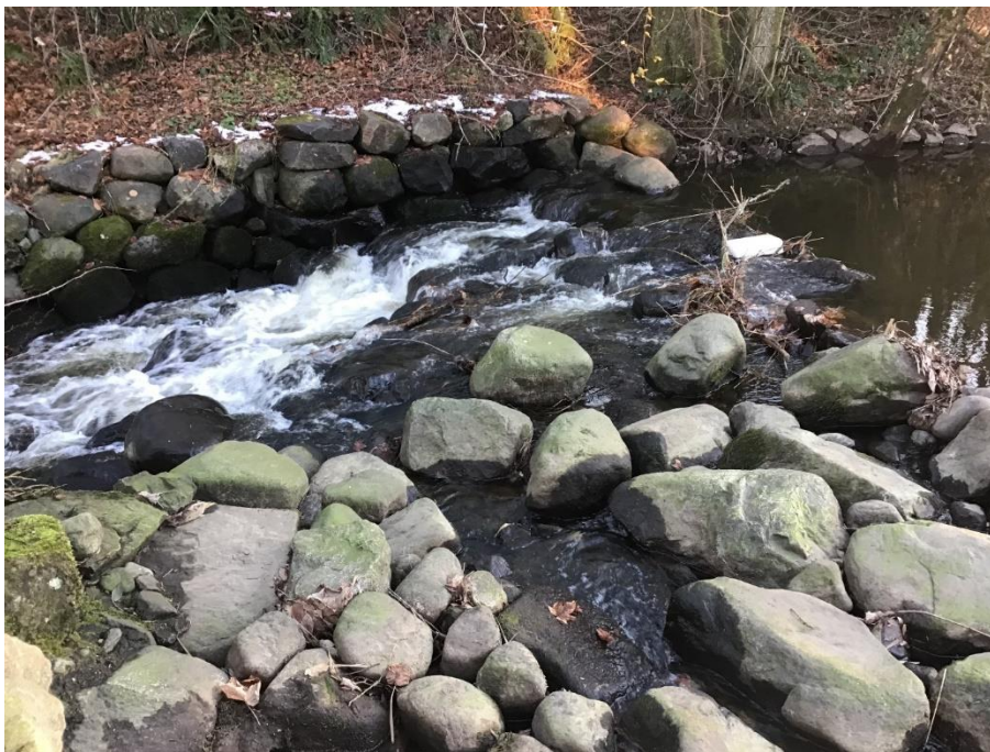
Figur 4.19. Vandringshinder nedstrøms dammen ved Skeilunden, slik den ser ut etter justeringstiltak.
