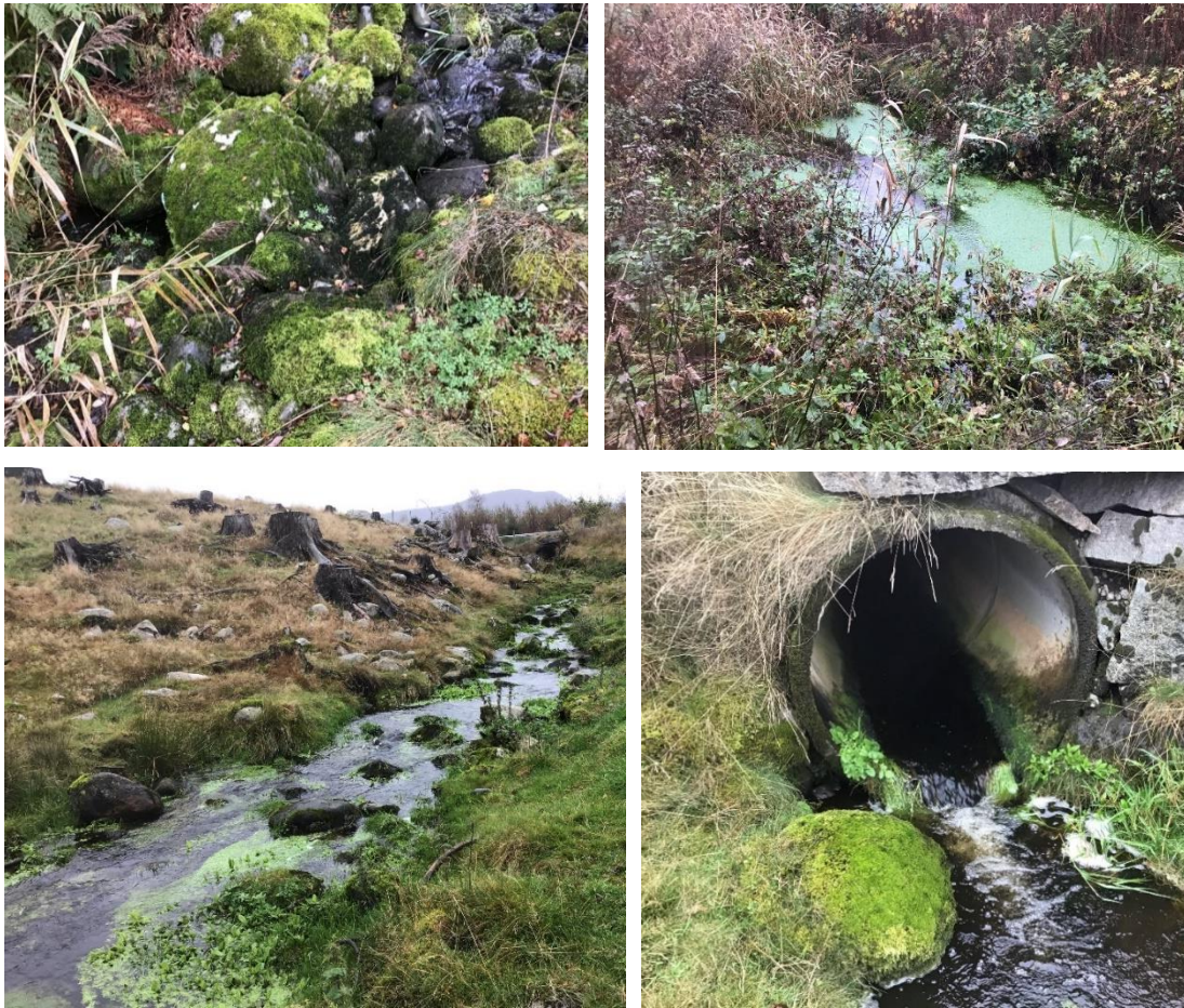
Figur 9.8: ØV: Steinfylling ved rensepark er et temporært vandringshinder. ØH: Det er anlagt en rensedam sterkt gjengrodd med takrør og andre sumplanter. NV: Bekken renner åpent gjennom beite/hogstflate. Bunnsubstrat består av en høy andel stein og er ellers kraftig begrodd med mose og vannplanter. NH: Rør under Espelandsveien.
