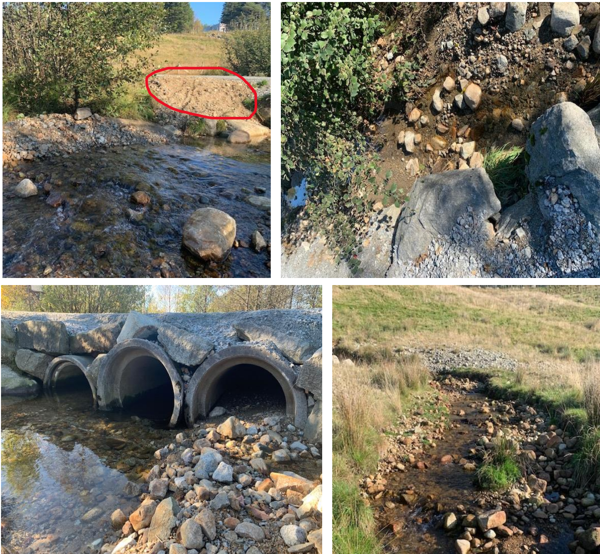
Figur 8.6: ØV: En stor ansamling sand ligger like ved bredden (rød linje). NV: Ett av rørene er tettet av sand og grus. Turstien er anlagt med fin grus med mye sand og steinstøv. ØH: Det er ingen fysiske sikringer av grusen i turstien. Det er synlig avrenning av grus, sand og finstoff fra denne til bekken. NH: Stein og grus dominerer i øvre del. Omdisponering av eksisterende stein vil kunne øke tilgjengelig skjul. Øvre deler av bekken har ingen funksjonell kantvegetasjon. Løpet i øvre del bør ideelt bearbeides for å gi mer variasjon i dybder, bredder og skjultilgang, samtidig som det må tåle flom.
