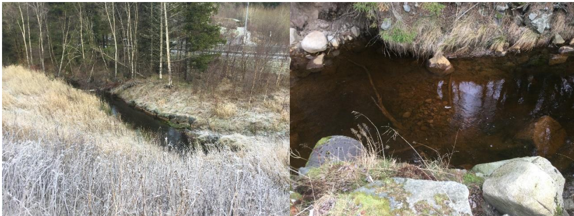
Figur 5.45. Venstre: Øvre del av sona har stort sett kun grasvegetasjon i kantsona. Det er viktig å plante inn gunstige arter om svartor og vier. Høyre: Det er relativt dypt i sona, også på steder med noe gytegrus fra før. Det må legges ut et relativt tykt lag med gytegrus, og helst kombinere med å legge ut noe habitatstein i områdene rundt.
