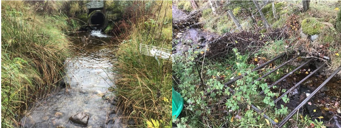
Figur 10.6. Venstre: Rør under Espedalveien ligger litt høyt, og bygging av en steinterskel litt nedstrøms som hever vannet noe vil lette oppgangen. Høyre: Sammenrast gjerde som har mye ansamlet materiale utgjør et tilnærmet stengsel for fisken.
