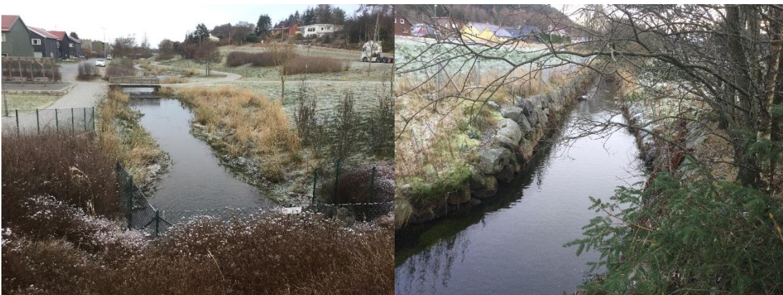
Figur 5.13. V: Samme glattstrømsone ved Brattebø. H: Kanalisert og erosjonssikret grunnområde oppstrøms Brattebø, nær E39.
