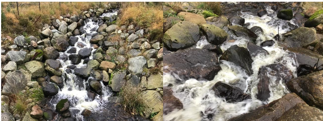
Figur 7.2. ØV: Rista nederst i den åpne delen av bekken. Sandfangkum kan skimtes bak rista. Blokker er lagt ut for å sikre åpning inn mot to litt større åpninger (under vann). ØH: Løpet oppstrøms rista er bearbeidet. En rekke blokker i løpet skal bidra til å redusere erosjon av materiale ned mot rista, samt sikre vandringsvei for fisk gjennom åpninger i rista. NV: Stryk er dominerende utforming i bekken, fra nedre strykparti. Gamle erosjonssikring i kanter. NH: Øvre del av tilgjengelig løp har naturlig løp og kanter, med fine og varierte forhold
