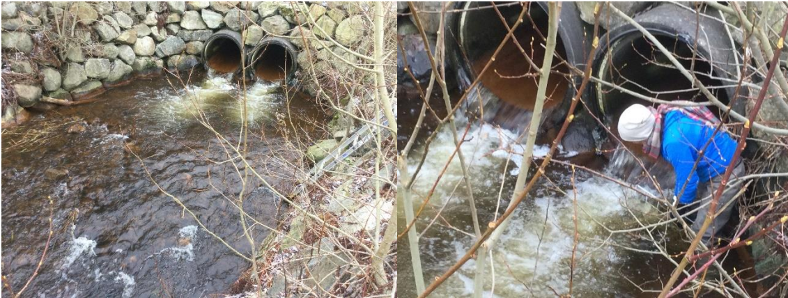
Figur 5.30. Vandringshinderet/-stengselet ved Bjønnbåsen, sett fra nedsiden. Utplassering av tilpasset steinblokk til høyre for rørutløpet kan sikre ål inngang til et rør. Det er viktig at spranggropen for anadrom fisk samtidig bevares. Vannnivået i øvre del av kulpen bør heves ved etablering av en steinterskel. Tiltak inne i minst 1 av rørene og noen tiltak på oppsiden av rør vil også være nødvendige.
