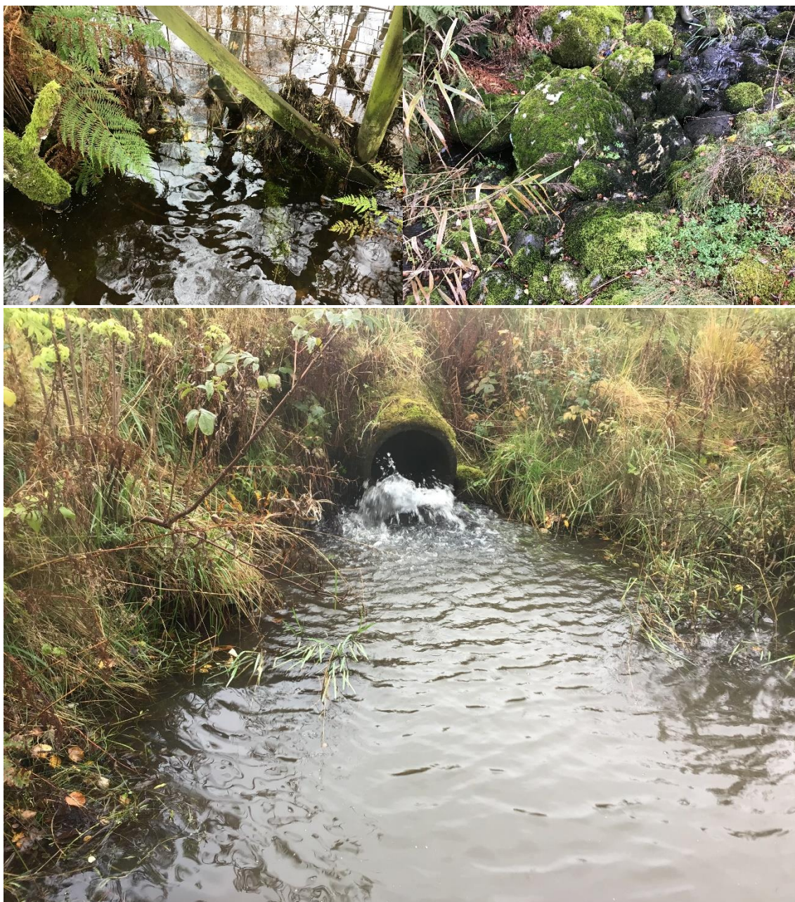
Figur 9.11. ØV: Nederste vandringshinder i form av gjerde ved Rogaland hundepark. ØH: Område nedenfor rensesepark der vannet forsvinner i blokk og stein, og forhindrer fiskevandring. Nederst: Uheldig plassert stein foran rør ved Espelandsveien, som gjør det vanskelig for fisk å ta seg videre til andre siden av veien. Som bildet viser er bekkevannet her sterkt farget.
