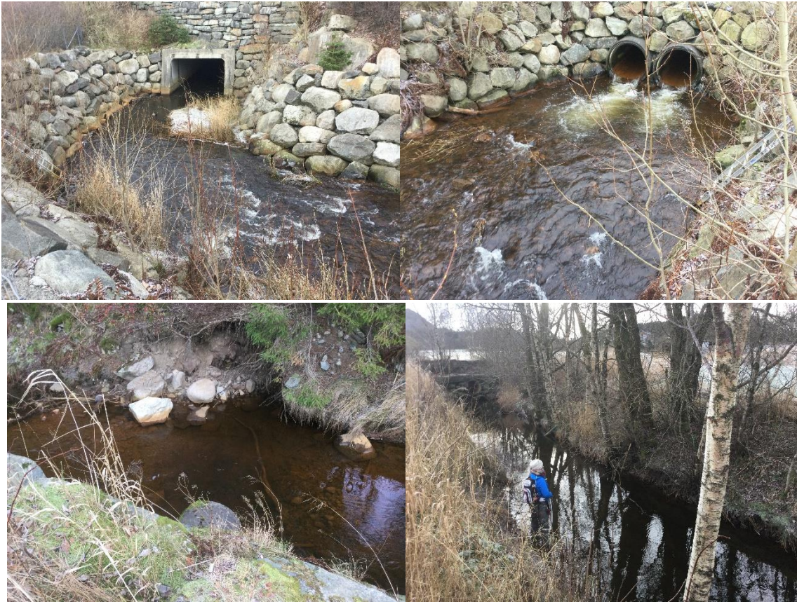
Figur 5.14. ØV: Nedre del av bearbeidet løp ved Bjønnbåsen, og kulvert under E39. Omfattende erosjonssikring i kanter. Løpet har mer stein enn ellers i elva, men på grunn av manglende kantvegetasjon er begroingen sterk. Det ser også ut til å være mye utfelling av jern/humus. ØH: Øvre del av samme sone, er inngangen til 2 rør på 42 meter lengde. Rørene ble i 2017 vurdert å være vandringsstengsler for fisk. Undersøkelser i 2021 støtter opp om at rørene trolig er sterkt begrensende for fiskens vandringsmulighet. Ved elfiske var dette den siste sona det ble funnet ungfisk av laks. 3 soner over rør hadde svært lave tettheter av ørret, og på to stasjoner ble det fanget fisk som kan være hybrid av ørret og laks (se avsnitt om ungfiskhabitat og fiskeundersøkelser). NV: Over rør ved Bjønnbåsen er det litt glattstrømsoner uten erosjonssikrede kanter. Her er noen små partier med gytegrus, og lokalt bedre forhold med noe blokk og stein i løpet. NV: Over dette er Bråsteinkanalen monoton med grunnområder og noen mindre kulpområder. Mudder og sand dominerer bunnsubstrat.
