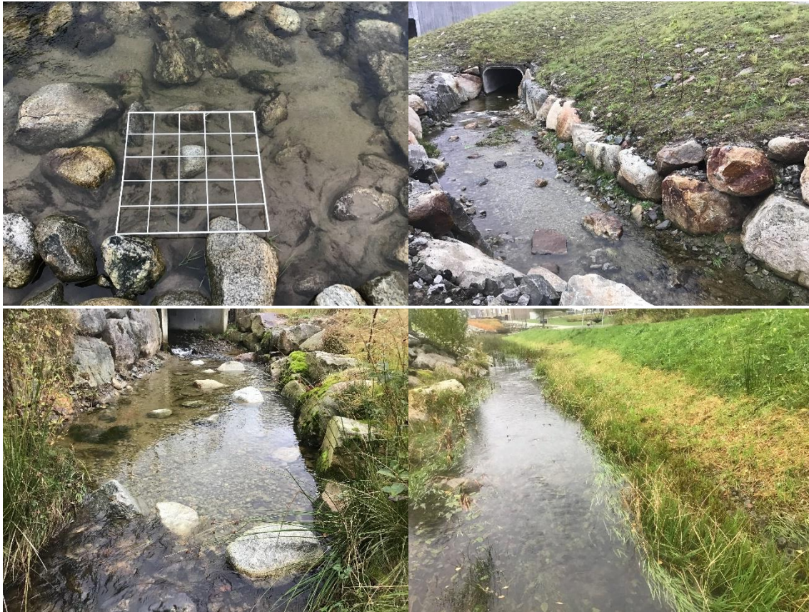
Figur 6.11. ØV: Store mengder sand og silt er svært negativt for skjul og gytegrus. Uten forurensning med finstoff ville bekken hatt bedre skjulforhold. ØH: Åpen del mellom to kulverter i nedre del ved det viktigste gyteområdet, hvor det ble lagt ut gytegrus og habitatstein, samt plantet noe gråor. NV: Øverst i den naturpregede sonen ble eksisterende gytegrus supplert, brekket ble forsterket med noen blokker og det ble lagt ut noe habitatstein. Masser med finstoff ble først fjernet, og eksisterende grus ble harvet. NH: Fra glattstrøm helt øverst i bekken. Selv om busker og trær mangler, er det mange steder grasvegetasjon langs bekken. Her viser en svært uheldig kantslått langs bekken (brudd på Vannressurslovens § 11).
