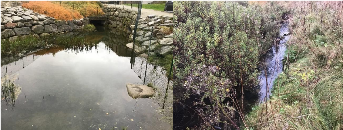
Figur 6.5 V: Det midtre grunnområdet (dam) i boligområdet, med omfattende erosjonssikring i kanter. Kulvertåpning sees bak i bildet. H: En mindre del av bekken har naturlig løp, her med mye pors langs kanten.
