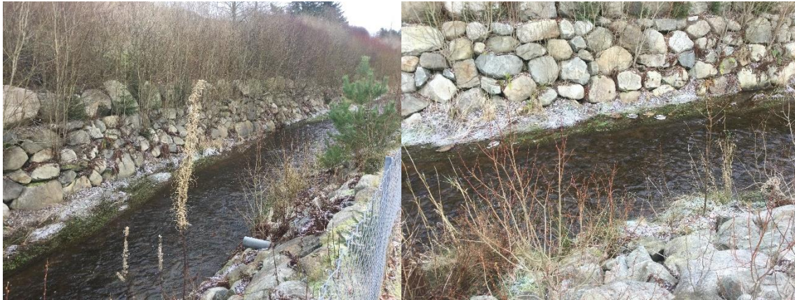
Figur 5.43. Venstre: Det er mye naturlig tilvekst av selje i plastringene. På vestsida ryddes det trolig mer lauvoppslag enn på østsida. Det er viktig at det på østsida etableres høye og skyggende trær over steinplastring. Samtidig bør det på begge sider plantes svartor og vier ned mot elva på steder der rotsystem i liten grad blir i konflikt med steinplastring. Det antas at mye av den naturlige tilveksten kommer til å hogges for å unngå rotsprengning i plastringene.
