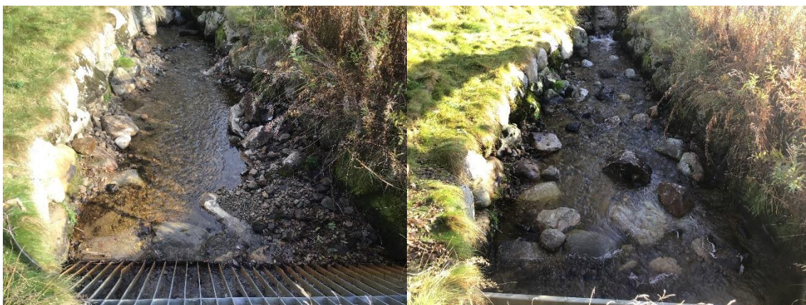
Figur 7.8. Venstre: Rista og område oppstrøms før tiltak. Rista er rensket for greiner, men mye grus og stein har lagt seg over nedre kant. Høyre: Etter flytting av grus og stein oppover i løpet, og utplassering av blokker for å sikre vandringsvei via to litt større åpninger.
