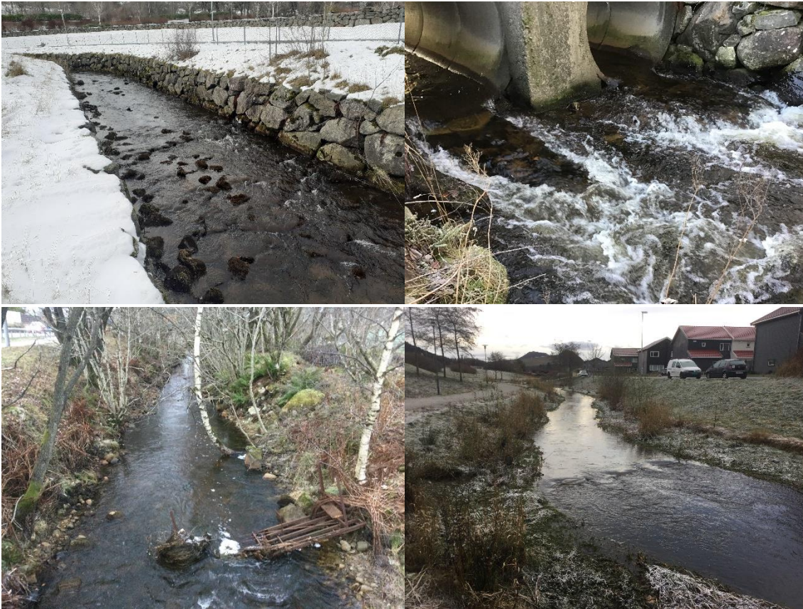
Figur 5.12. ØV: Nyere omlegging av løp ved Høyland kirke, med erosjonssikrede kanter i strykparti. Denne stryksområdet har mer stein enn de fleste andre soner i elva. ØH: Rør under Melsheiveien er fortsatt temporært vandringshinder for fisk ved lav vannføring. Flat betong under utløp rør gir lav vanddybde ved lav vannføring. NV: Glattstrøm nedstrøms rørlagt del av elva ved Kleivaneveien. Her er det både glattstrøm og noe stryk. NH: Glattstrøm over samme rørlagte del, ved Brattebø. Løpet og bunnsstrat er her lagt om og endret i forbindelse med opparbeiding av området. Løpet har noe mer variasjon i kurvatur, og det er lagt ut store mengder rullestein (70% stein). På grunn av manglende kantvegetasjon er det mye begroing i sonen. Det finnes ikke gyttegrus på hele denne 500 meter lange sonen, selv om elveklassen glattstrøm er godt egnet for gyttegrus.
