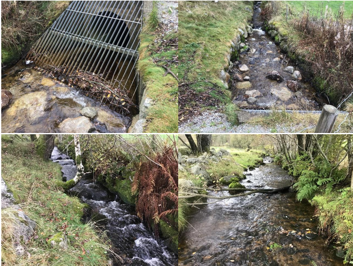
Figur 7.2. ØV: Rista nederst i den åpne delen av bekken. Sandfangkum kan skimtes bak rista. Blokker er lagt ut for å sikre åpning inn mot to litt større åpninger (under vann). ØH: Løpet oppstrøms rista er bearbeidet. En rekke blokker i løpet skal bidra til å redusere erosjon av materiale ned mot rista, samt sikre vandringsvei for fisk gjennom åpninger i rista. NV: Stryk er dominerende utforming i bekken, fra nedre strykparti. Gamle erosjonssikring i kanter. NH: Øvre del av tilgjengelig løp har naturlig løp og kanter, med fine og varierte forhold
