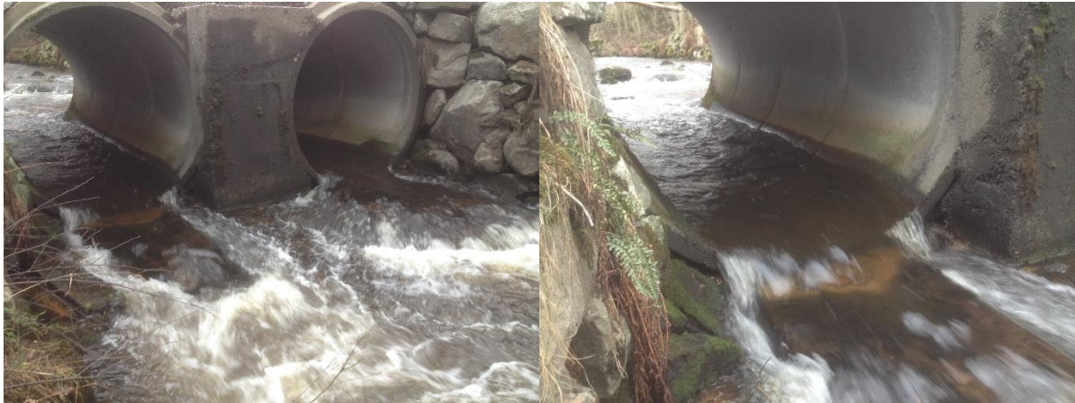
Figur 5.29: Vandringshinder under Melsheiveien. Den enkleste måten å utbedre hinderet på er å lage en terskel nedstrøms rørene for å heve vannstanden under rørene noe. Foto: Rune Søyland 2017
