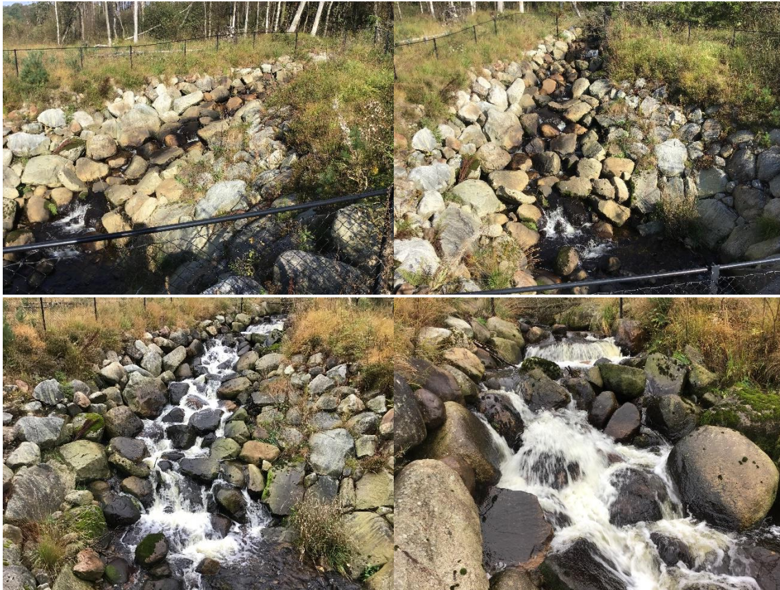
Figur 7.10. Bilder av tiltak 3. Øverst: Stengsel fra siden og forfra ved lav vannføring. Nederst: Stengsel sett ved høyere vannføring. Bildene er tatt ovenfra fra veien, og fallet ser dermed mindre ut enn det er.
