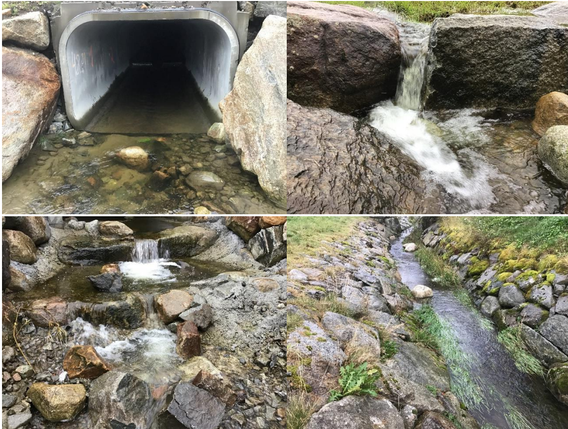
Figur 6.6ØV: Bokskulvert nedre halvdel der det er satt inn stålplater med V-terskel for å lette fiskevandring. Legg merke til transportert sand på vestre side av løpet. ØH: Terskel under den øvre dammen, bearbeidet i 2021 for å lette oppgang for fisk. NV: Vandringshinder nedstrøms den nest øverste kulverten ble utbedret i 2021. NH: Plastrede kanter i glattstrøm i øvre halvdel av bekken, med lokalt mer vannvegetasjon i bunnen.
